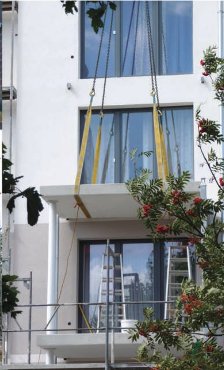
Die neuen Balkone werden montiert.
