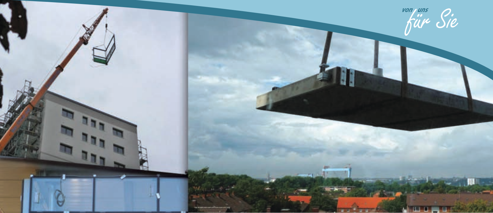
Die neuen Balkone werden montiert.
